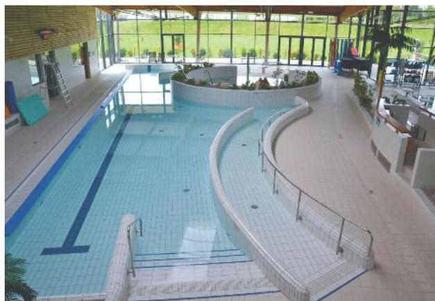
Rampe bordée d'un muret et d'une main courante - Piscine « Belle Étoile » (76).
